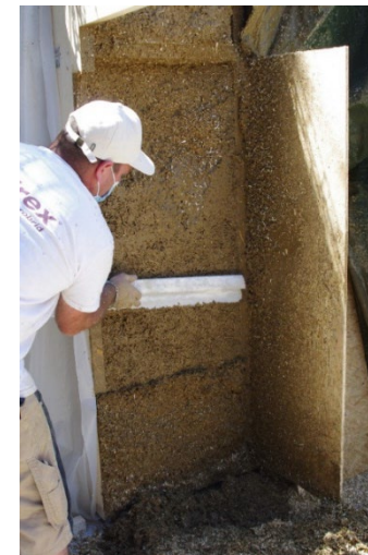
Arasement de la surface
